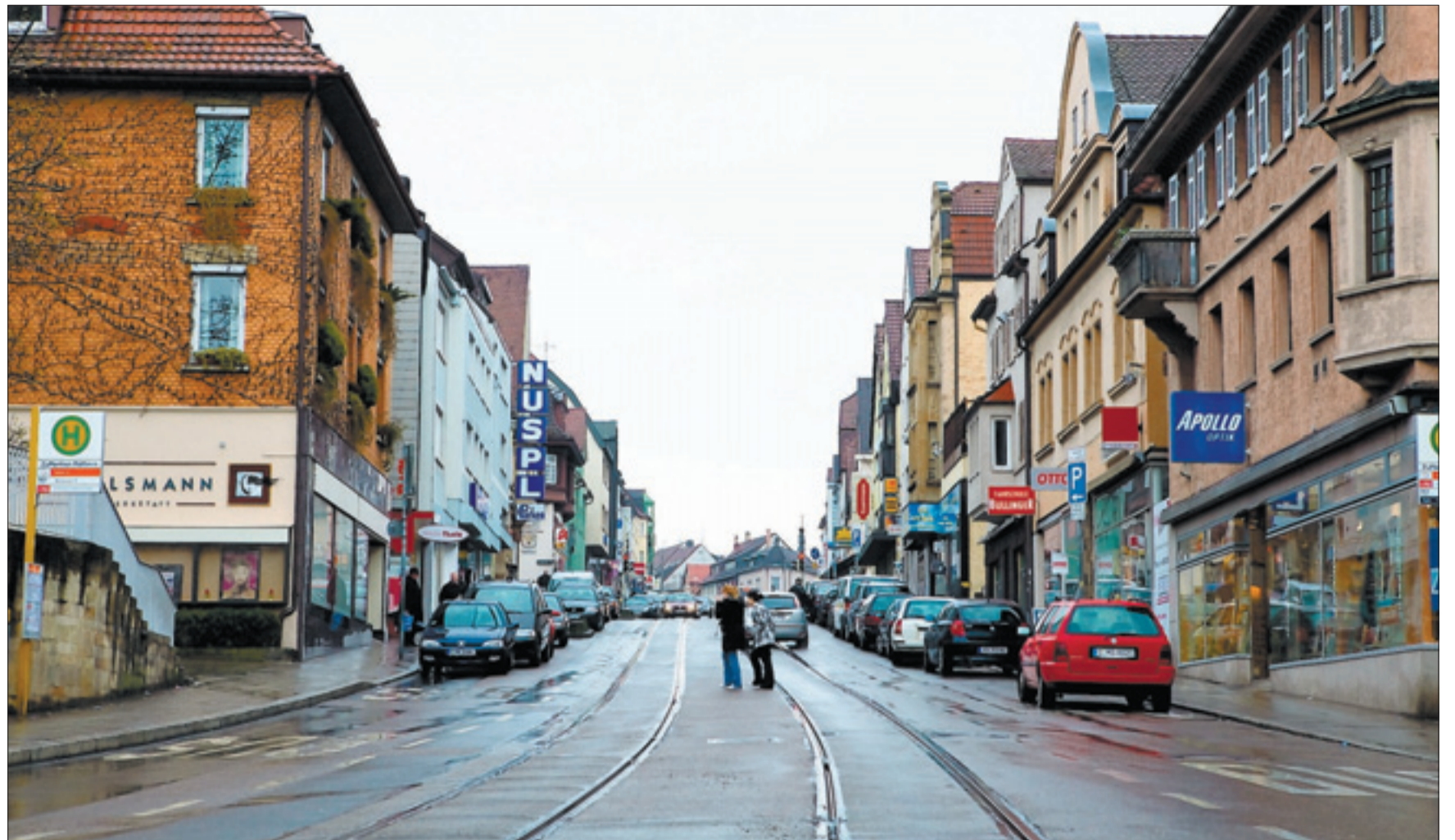
Brennpunkt Unterländer Straße: Die angeschlagene Einkaufsmeile und Lebensader von Zuffenhausen wird für die Stadtbahn untertunnelt
